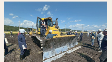
ICT施工現場見学会(谷地田地区)
