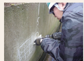
中性化深さ調査実施状況
