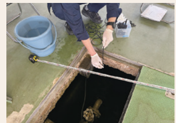
処理水槽の汚泥沈殿調査状況
