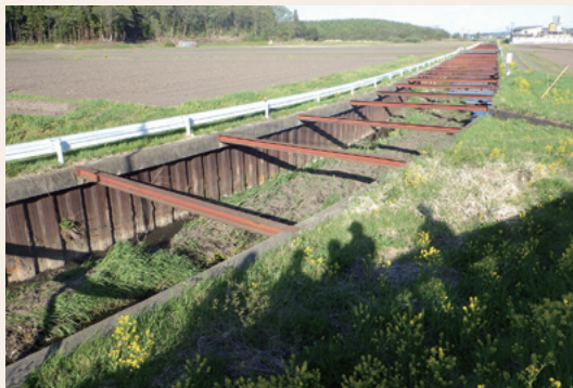
排水路の対策前
