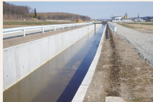
排水路の対策後
